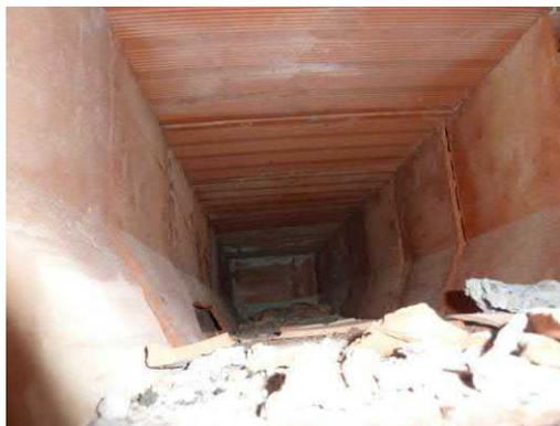
Analisi endoscopica interno del solaio
