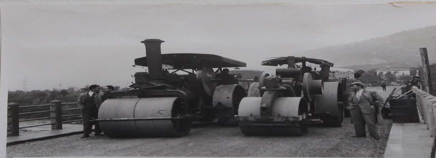
fig. 2 - Carico B, costituito da due rulli e due autocarri a pieno carico, sulla chiave dell' arcata - P_{tot} = 73,4 \text{ tonn.}
